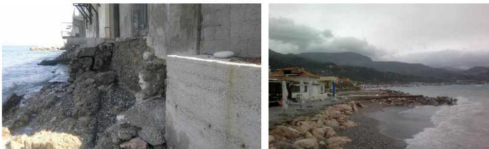
Figure 28 - Murs de protection contre l'érosion côtière
