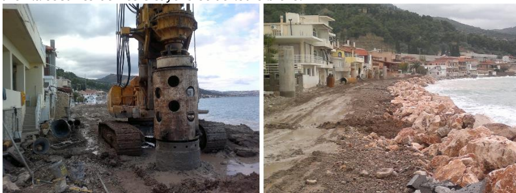
Figure 29 - Construction d'un chemin en bord de mer (1)
