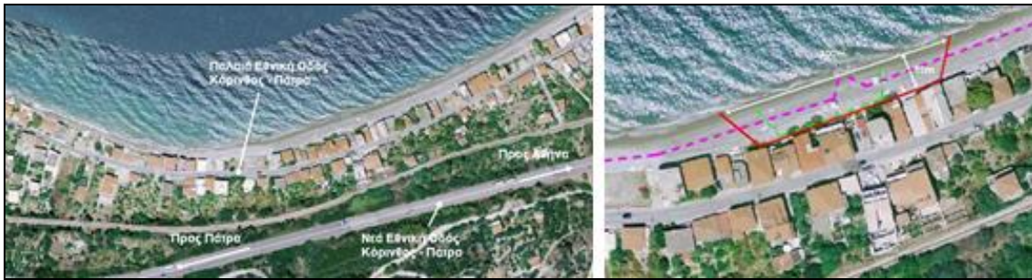
Figure 25 - Erosion côtière à Derveni
