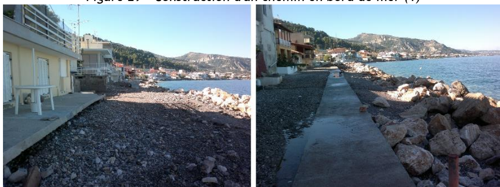
Figure 30 - Construction d'un chemin en bord de mer(2)
